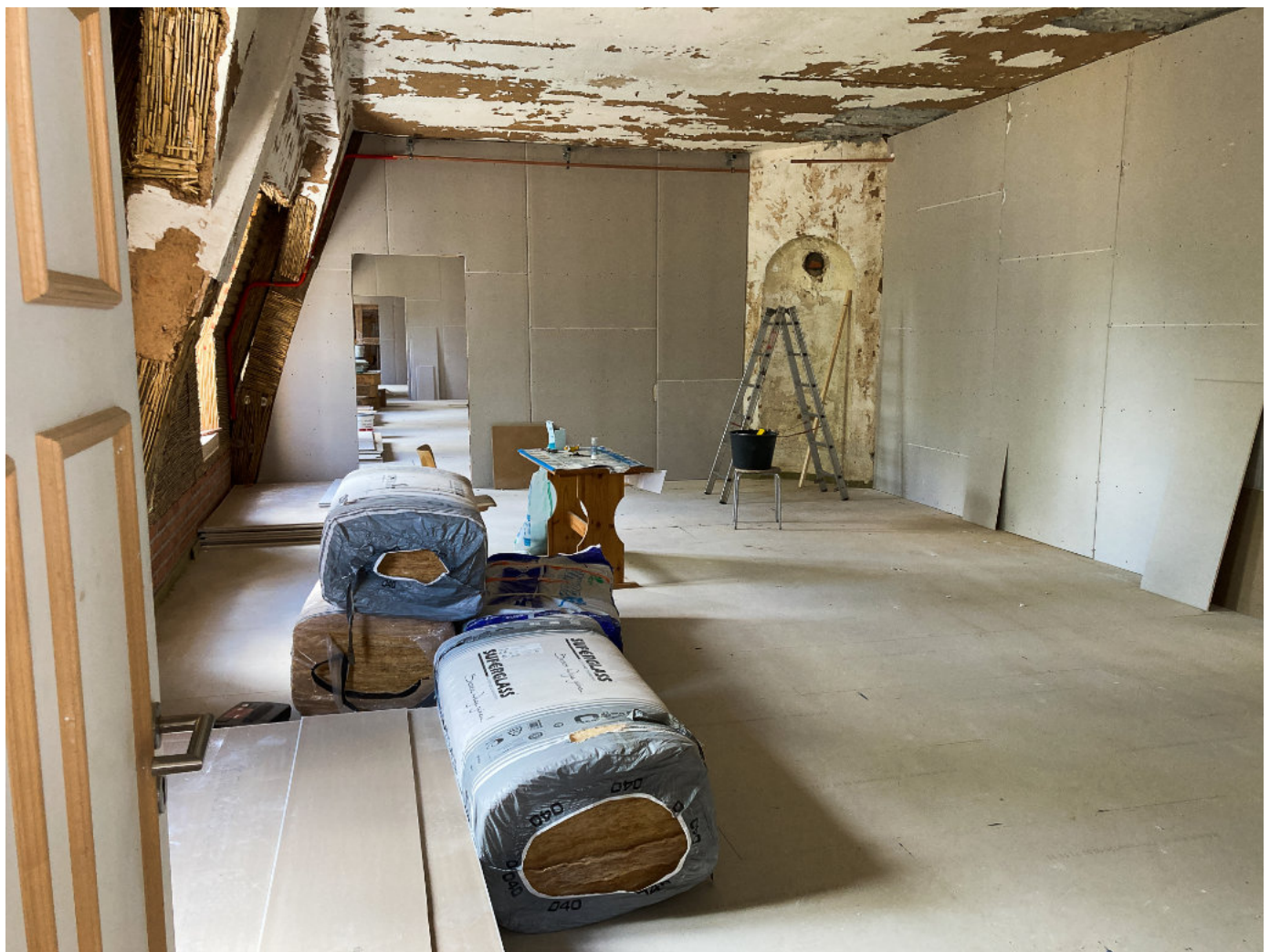
Die Baustelle des Papiertheatermuseums am 12. Juli 2022
